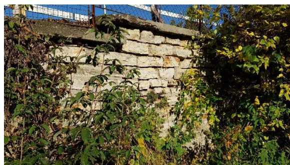
Obr. 09 – Pohled na horní opěrnou zeď v místě vybočující římso.
