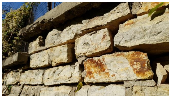
Obr. 10 – Dtto Obr. 09 – detailní pohled – malta kompletně degradována, místo kamenné zdi se jedná pouze o volně poskládané kamenivo
