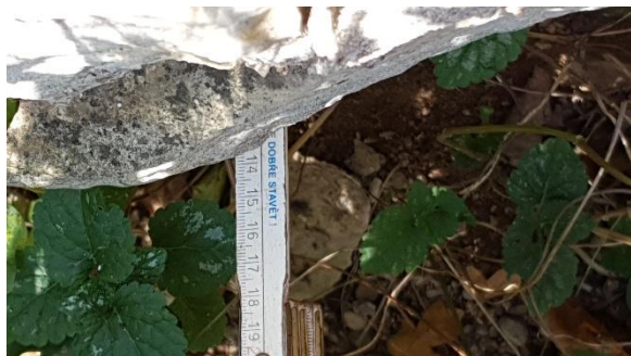
Obr. 14 – V některých místech opěrné zdi dochází k vytlačování kamenů ze zdi až o 140 mm.
