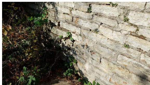
Obr. 13 – Vlivem zemního tlaku dochází k vytlačování jednotlivých kamenů ze zdiva opěrné zdi v místě paty horní opěrné zdi
