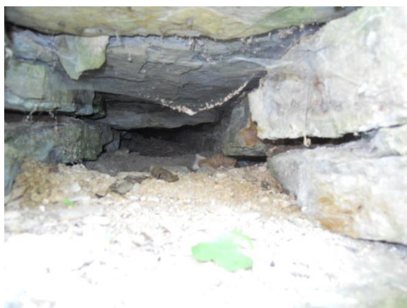
Obr. 20 – Pohled do konstrukce opěrné zdi v místě vypadlého kamene – je vidět kompletní rozpad malty v celé tloušťce zdi
