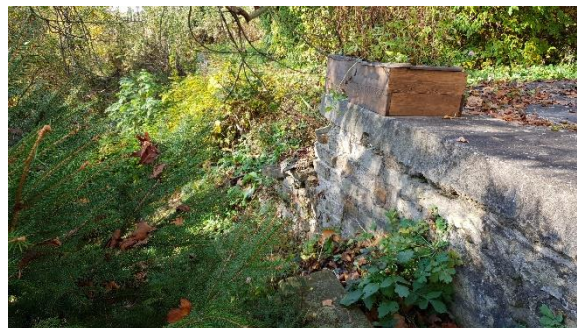
Obr. 15 – Pohled na vyvalenou spodní zeď.
