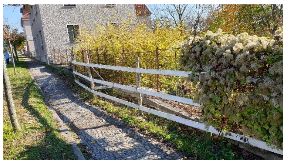
Obr. 08 – Vybočená římso – vyklánění opěrné zdi, propad chodníku
