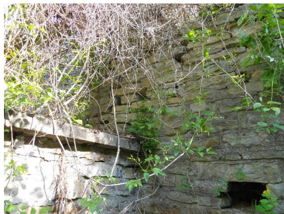
Obr. 19 – Dolní opěrná zeď – ve zdivu chybí malta, některé kameny již vypadly úplně.
