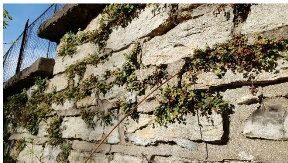
Obr. 12 – Horní opěrná zeď – degradace pojiva – ve spárách se uchytila vegetace
