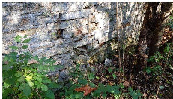
Obr. 17 – Dolní opěrná zeď – pata zdi – uvolněné a vypadané kameny
