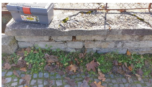
Obr. 04 – Pohled na opěrnou zeď nad chodníkem – degradovaný beton římsy, uvolněné kameny zdi, chybějící malta.
