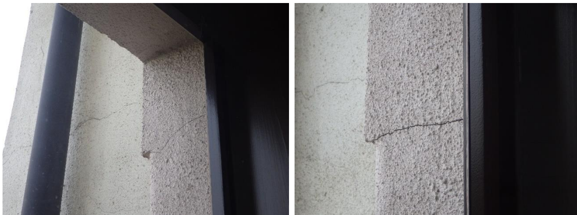
Foto č. 7– 1.NP – m.č. 108 –navazující šikmá trhlina z ostění okenního otvoru;
