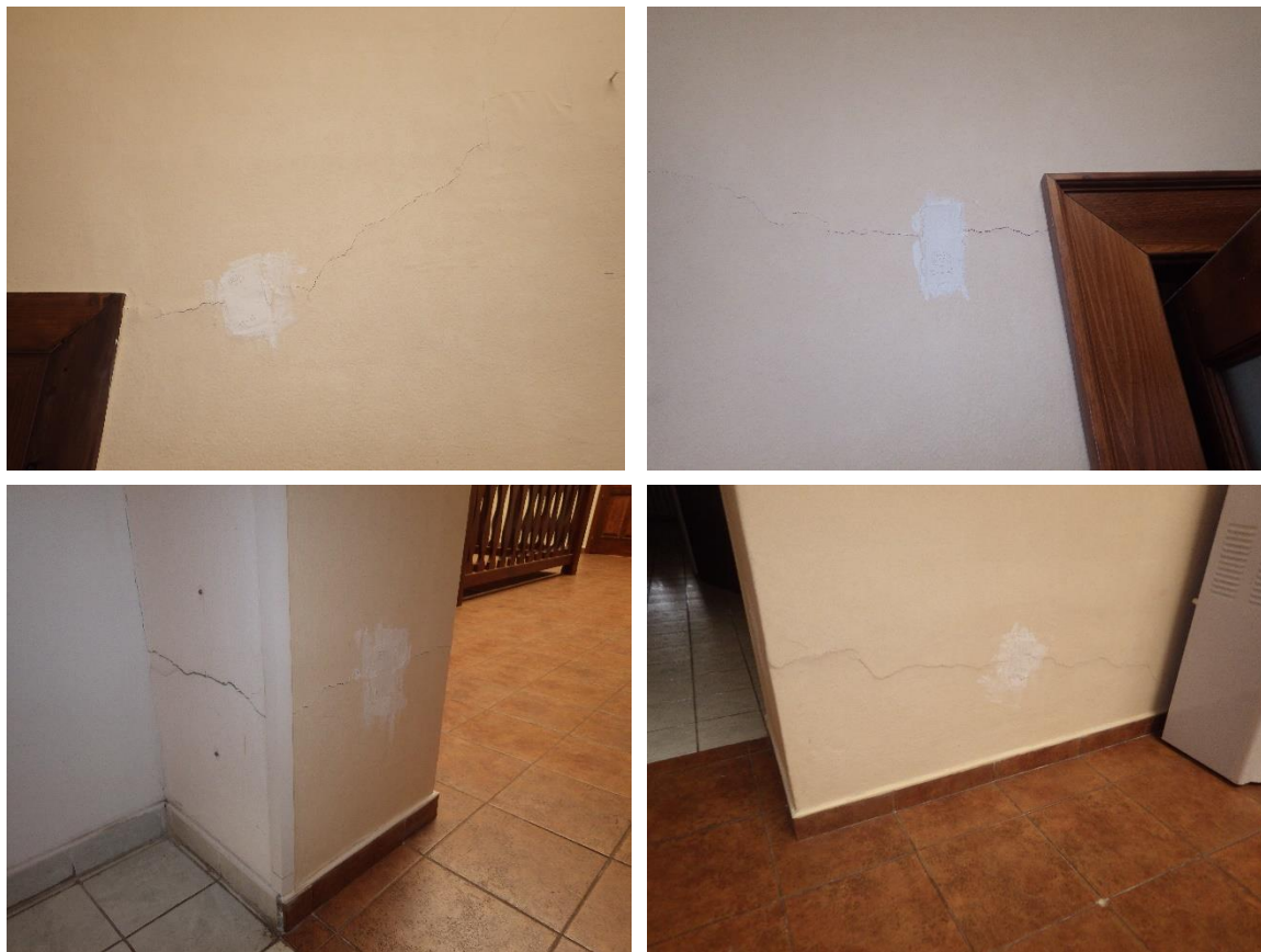
Foto č. 11 - 14 – 2.NP – m.č. 201 – vznik trhlin v nadpraží, dále výskyt vodorovných trhlin ve spodní části nosné stěny nad pilířem;
