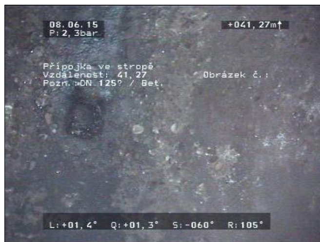
Obr. 4 41,3 m Připojka ve stropě
