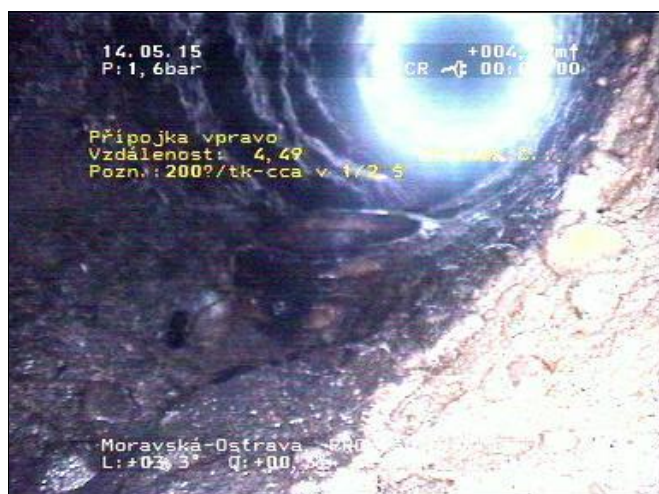
Obr. 50 4,5 m Přípojka vpravo
