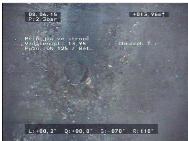
Obr. 3 14,0 m Připojka ve stropě
