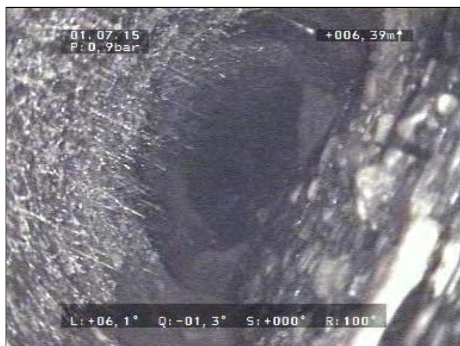
Obr. 46 0,9 m Chybějící úlomek - střep vpravo 15,00 cm
