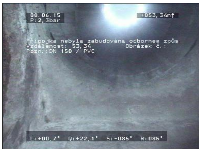
Obr. 9 53,3 m Přípojka nebyla zabudována odborným způsobem vlevo
