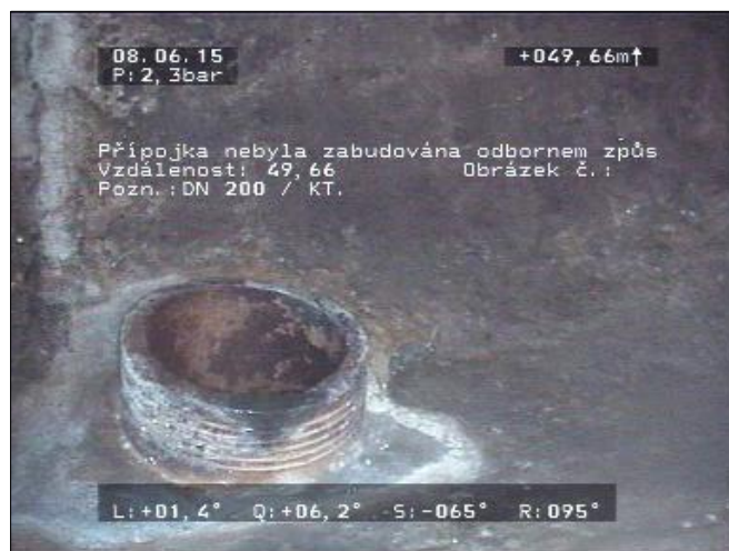
Obr. 8 49,7 m Přípojka nebyla zabudována odborným způsobem vlevo
