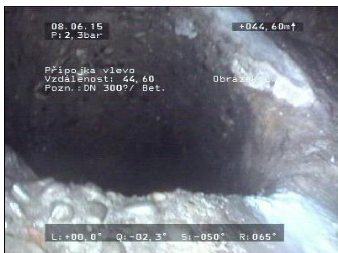
Obr. 5 44,6 m Připojka vlevo
