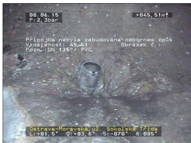
Obr. 6 45,5 m Připojka nebyla zabudována odborným způsobem vlevo
