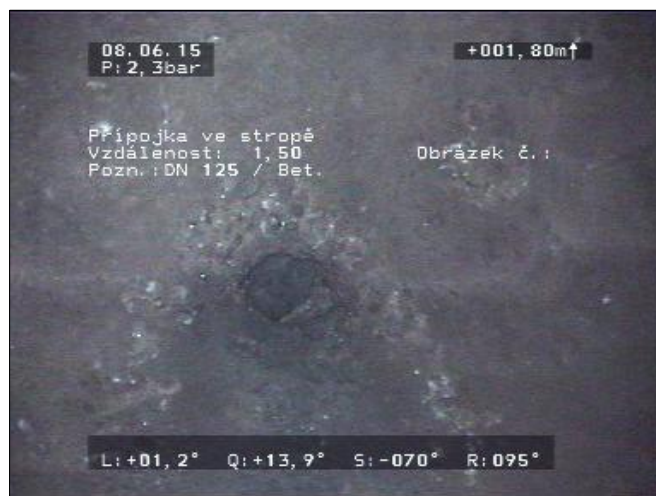
Obr. 2 1,5 m Připojka ve stropě
