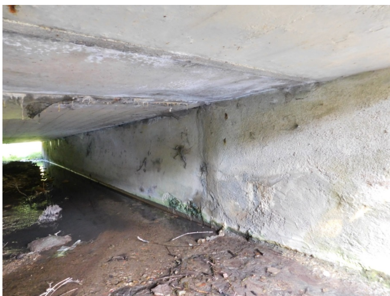
Obr. 4.3: Foto 717: Opěra O1, na fotce v levé části původní opěra, v pravé části rozšíření opěry pod prefabrikovanými nosníky, na opěrách stopy po zatékání, lokální rozpad povrchové vrstvy betonu.
