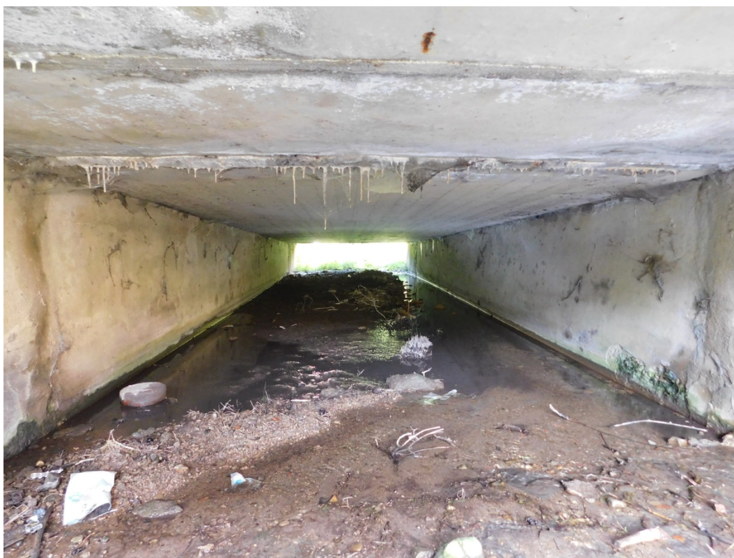
Obr. 2.5: Prostor pod mostem: na dně velké množství nánosů, bahna, opěry potečené, krápníky ze spáry mezi monolitickou deskou a prefabrikovanými nosníky
