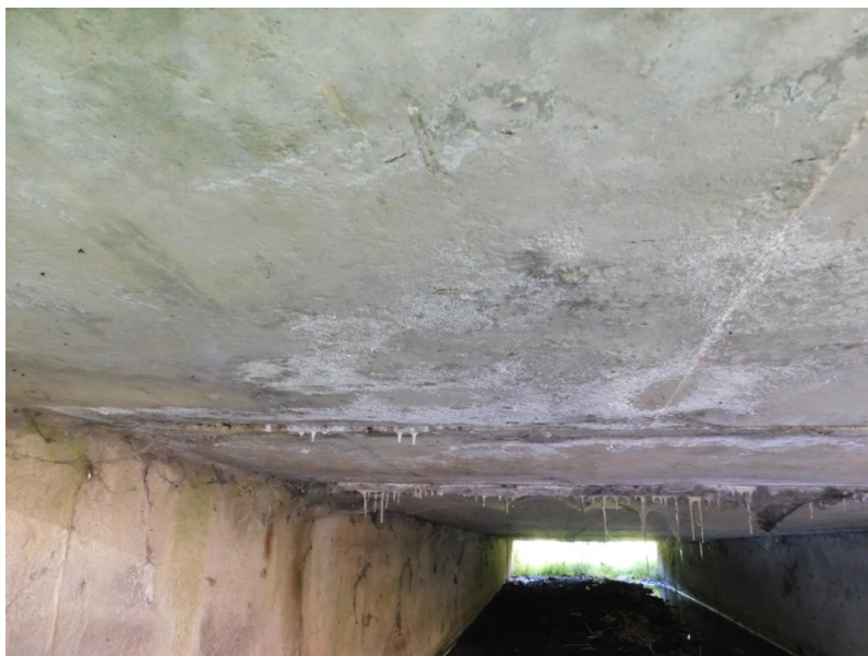
Obr. 4.5: Foto 716: Nosníky zdola: vápenné výluhy, stopy po zatékání, ve spáře mezi nosníky a ŽB monolitickou deskou tvorba krápníků, inkrustací.
