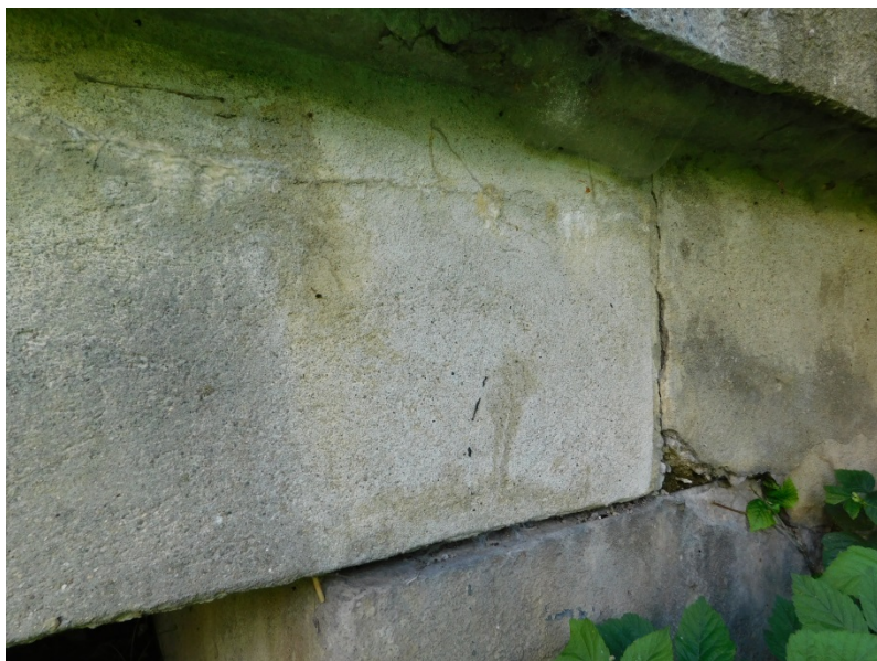
Obr. 4.8: Foto 753 – uložení nosné konstrukce na opěru O2 vpravo.
