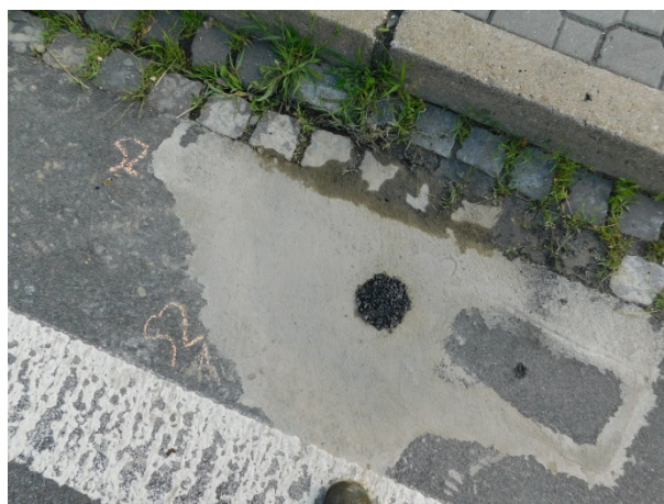
Zapravení sondy S2
