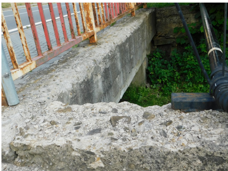
Obr. 4.10: Foto 885 – na římse a křídle vpravo rozpad betonu do hloubky 2 cm, strávený nátěr zábradlí, koroze.
