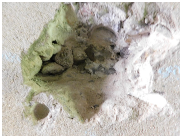
Obr. 4. 24: Sekaná sonda K1: úložný práh opěry O2, beton odsekán do hloubky 80 mm v místě vytipovaném radarem, nenalezena žádná výztuž, pouze štěrkové hnízdo.
