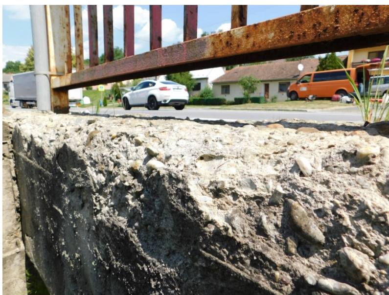
Obr. 4.9: Foto 752: Koroze betonu pravé římsy, povrchový rozpad betonu, koroze ocelového zábradlí.
