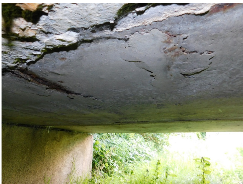
Obr. 4.7: Foto 743: Nosníky zdola, lokálně odhalená výztuž, lokální odprýskání povrchové betonové vrstvy.
