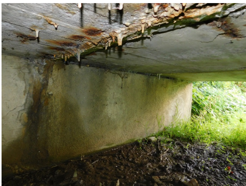
Obr. 4.6: Foto 741: Spára mezi nosníky a monolitickou deskou, pravá strana mostu, inkrustace, tvorba krápníků, v rozšíření opěry O2 výrazné stopy po zatečení, na dně velká vrstva bahenního nánosů, podchodná výška pouze 0,8 m.
