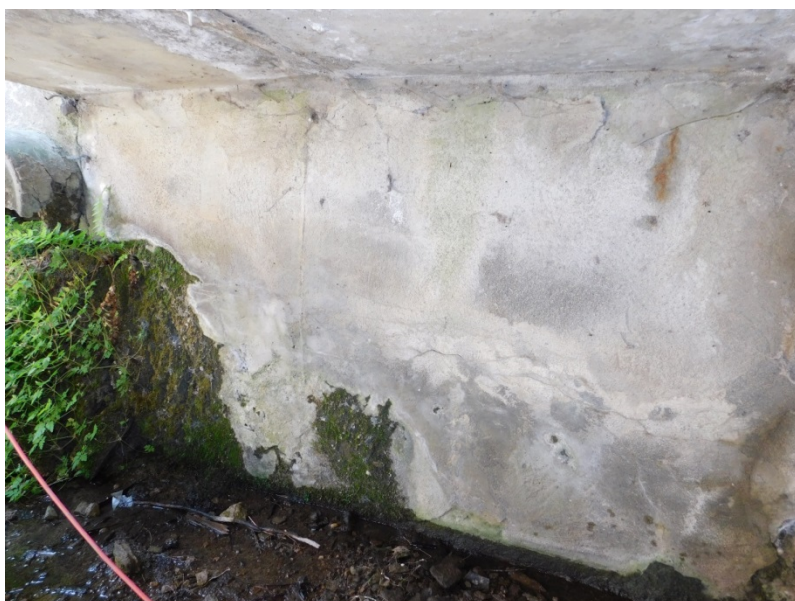
Obr. 4.4: Foto 727: Opěra O2, rozšíření pod nosníky, stopy po zatečení, mechový porost, lokální rozpad povrchové vrstvy.
