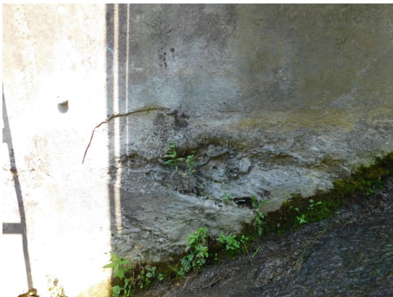
Obr. 4.2: Foto 725: Křídlo O1L, koroze betonu, rozpad povrchové vrstvy.
