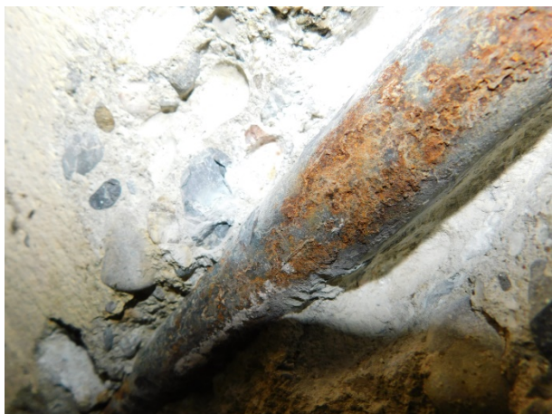
Obr. 4. 25: Sekaná sonda K3: nosná konstrukce (ŽB deska) zdola, hlavní nosná výztuž: prut \varnothing 24 mm, krytí pouze 8 mm, hladká výztuž, prut napaden povrchovou korozí.
