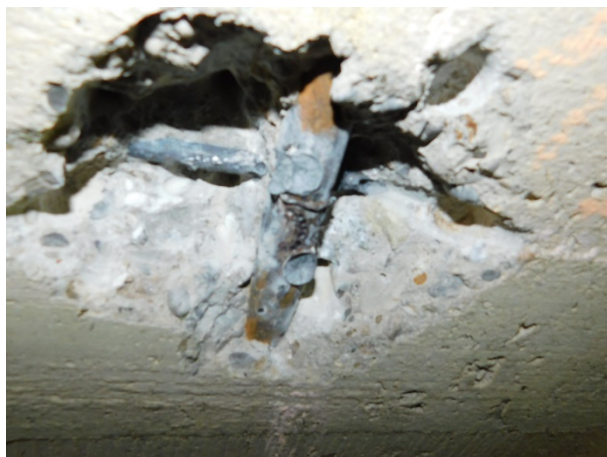
Obr. 4. 26: Sekaná sonda K4: (ŽB deska zdola, hlavní výztuž: prut hladký \varnothing 24 mm, krytí 16 mm, napaden povrchovou korozí, rozdělovací výztuž: prut hladký \varnothing 10 mm, krytí 40 mm, bez koroze.
