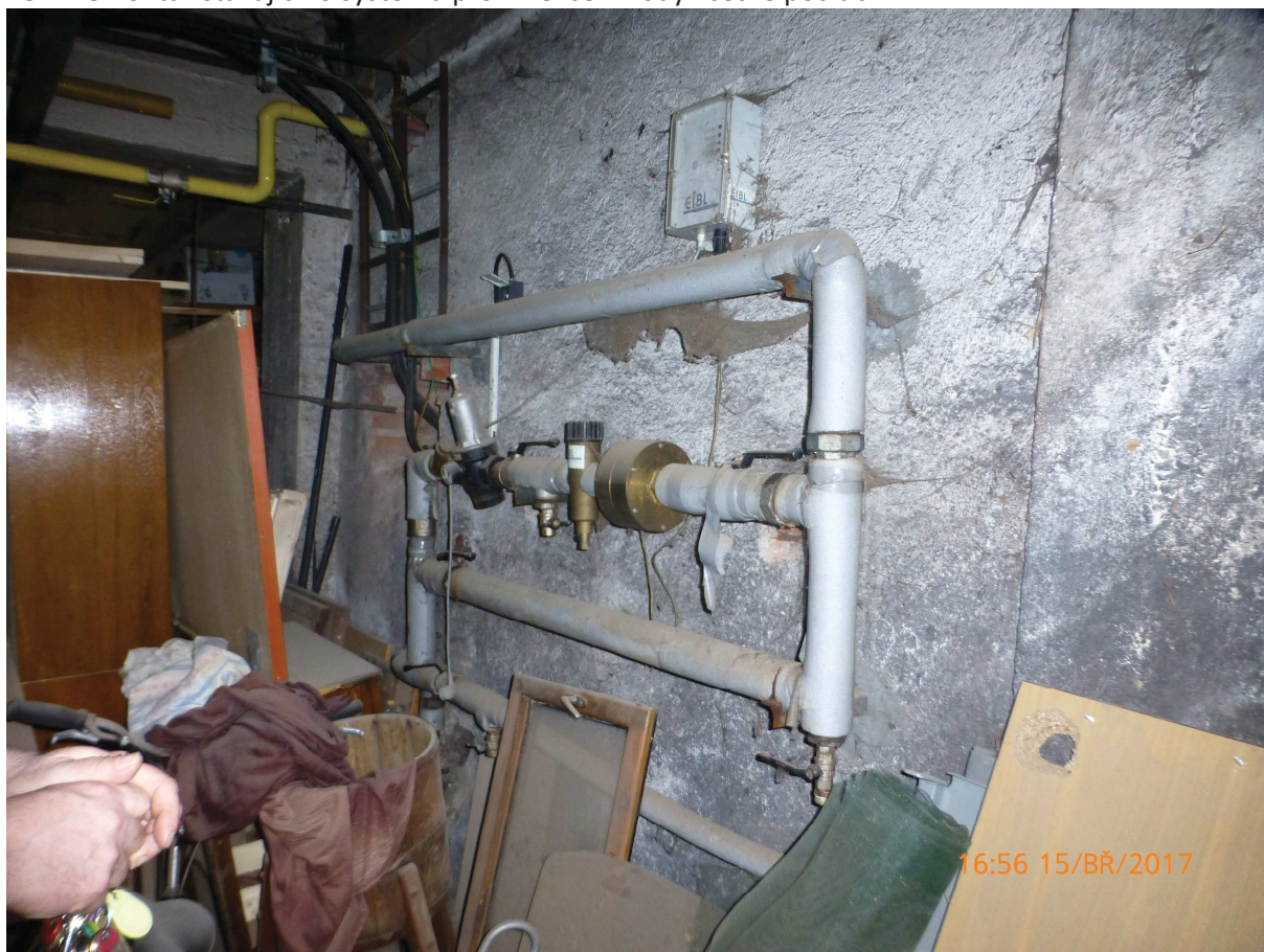
18 – Demontáž stávajícího systému pro změkčení vody včetně potrubí.
