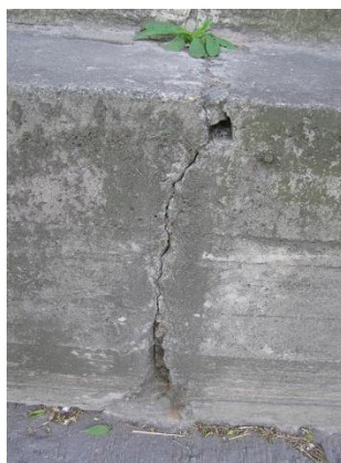
Podrobnost stavu svodidlové zídky – dochází k degradaci betonu v místě stávajících pracovních a dilatačních spár
