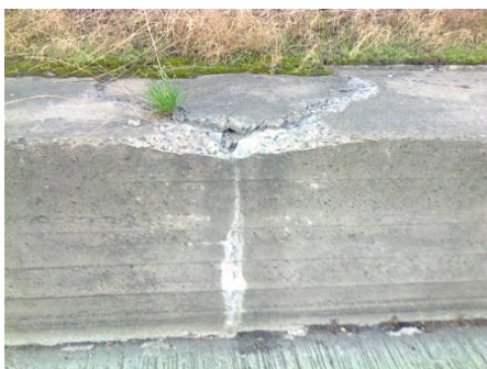
Podrobnost stavu svodidlové zídky – dochází k degradaci betonu v místě stávajících pracovních a dilatačních spár
