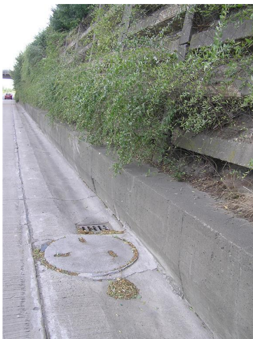
Pohled na odvodnění podél paty zdi
