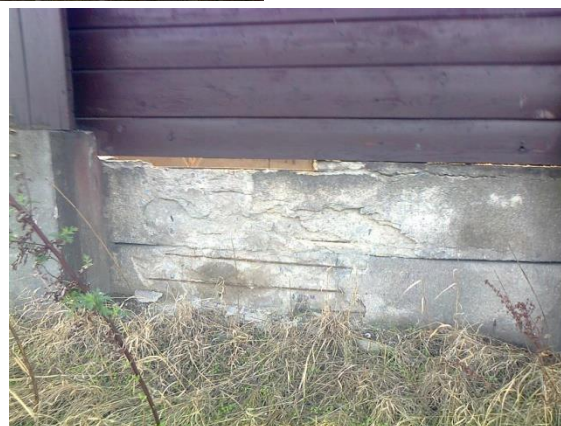
Podrobnosti stavu protihlukové zdi v km 0,712 – km 0,803 – dochází k degradaci betonu soklových panelů, k jejich rozpadu
