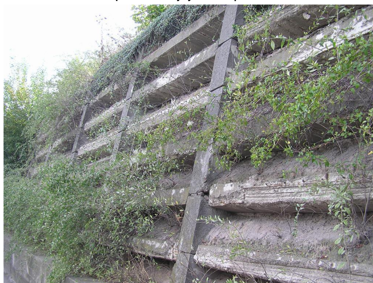
Detail konstrukce z prefabrikovaných dílů prosypávaných zeminou
