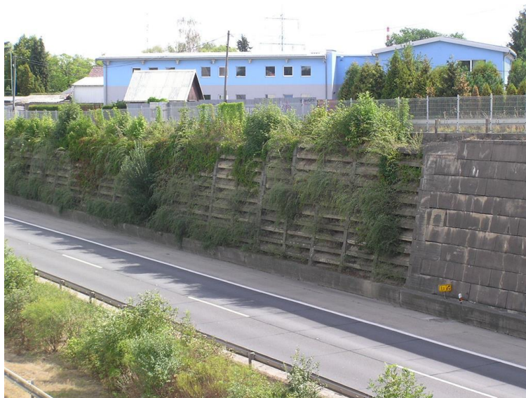
Pohled na zeď v místě přechodu mezi gravitační zdí a zdí z prefabrikátů prosypávaných zeminou
