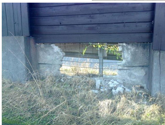
Podrobnosti stavu protihlukové zdi v km 0,712 – km 0,803 – dochází k degradaci betonu soklových panelů, k jejich rozpadu
