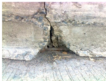
Podrobnost stavu svodidlové zídky – dochází k degradaci betonu v místě stávajících pracovních a dilatačních spár
