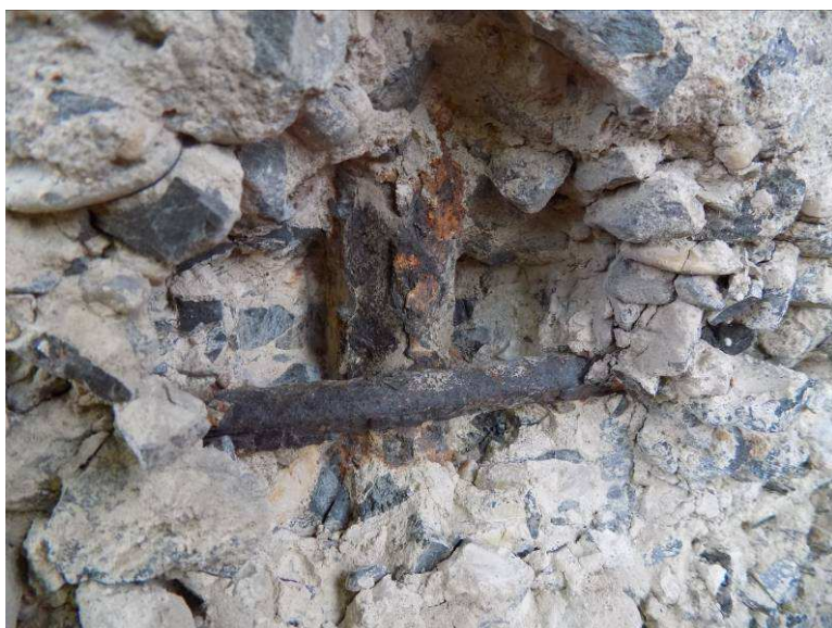
OV2 – P3 , pravý sloup, levá strana, cca 0,7 m nad terénem, v místě degradace a odpadlé krycí vrstvy.
