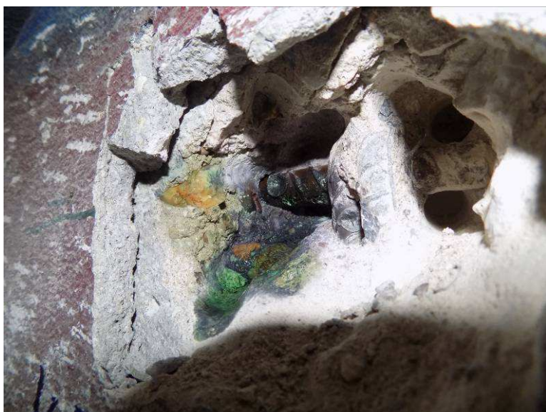
K5 – Opěra O5 , cca 0,1 m pod dolním lícem NK, cca 2,6 m od pravé svislé hrany O5, v místě OV4.
