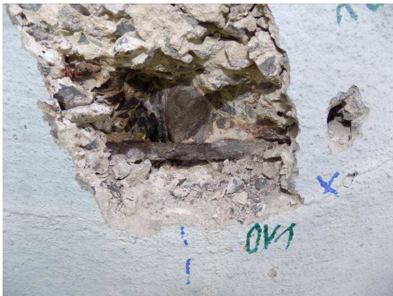
OV1 – P4 , pravý sloup, pravá strana, cca 1,5 m nad terénem, v místě trhlin a slabých výluhů.
